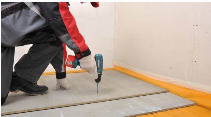
Рис. 9. Устройство сборной стяжки
