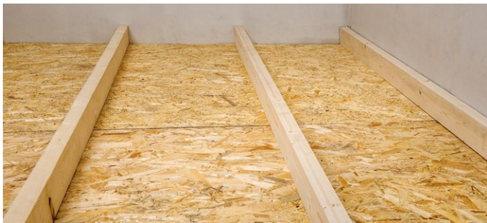
Рис. 1. Подшивка лаг снизу
