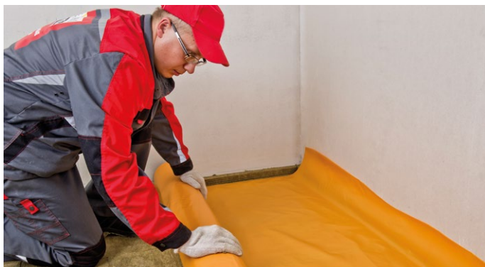
Рис. 8. Укладка гидроизоляции
