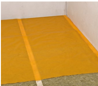
Рис. 3. Монтаж и проклейка нахлестов пароизоляционной пленки
