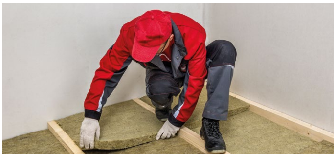
Рис. 2. Монтаж теплоизоляции враспор между лагами
