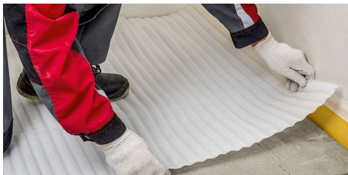
Рис. 12. Укладка подложки под финишное покрытие пола
