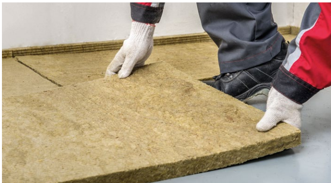
Рис. 7. Укладка плит ТЕХНОФЛОР СТАНДАРТ
