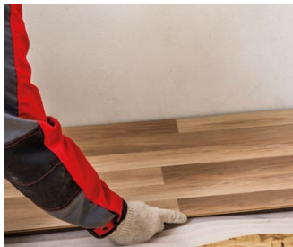
Рис. 5. Монтаж чистового покрытия
