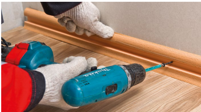
Рис. 16. Крепление плинтуса
